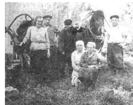
Лесной участок Ермаков Завод (Ермаки). Основной рабочей силой в военные и послевоенные годы были сезонники, трудармейцы, спецпереселенцы.
